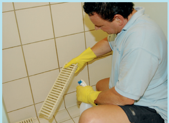
Ablagerungen in den Ablaufgittern waren bisher auch die Hauptursache für den als störend empfundenen Geruch. Die dafür verantwortlichen organischen Stoffe werden durch die Mikroorganismen abgebaut.
